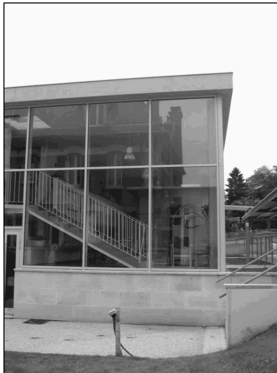
Figure 8. Vue de la pièce d'accueil (façade nord-ouest)
